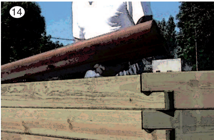
14 Positionner les margelles (J)
