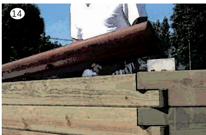
14 Positionner les margelles (J)
